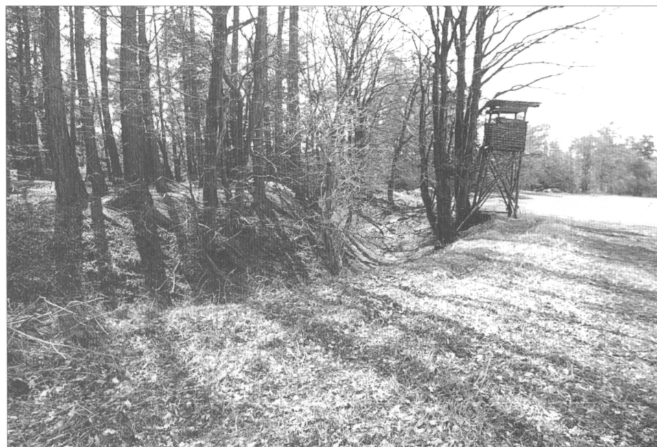
Obr. 6. Hořehledy, okr. Plzeň-jih. Vzrostlé stromy zpevňující svah příkopu tvrzíště. Foto autor 2002.
