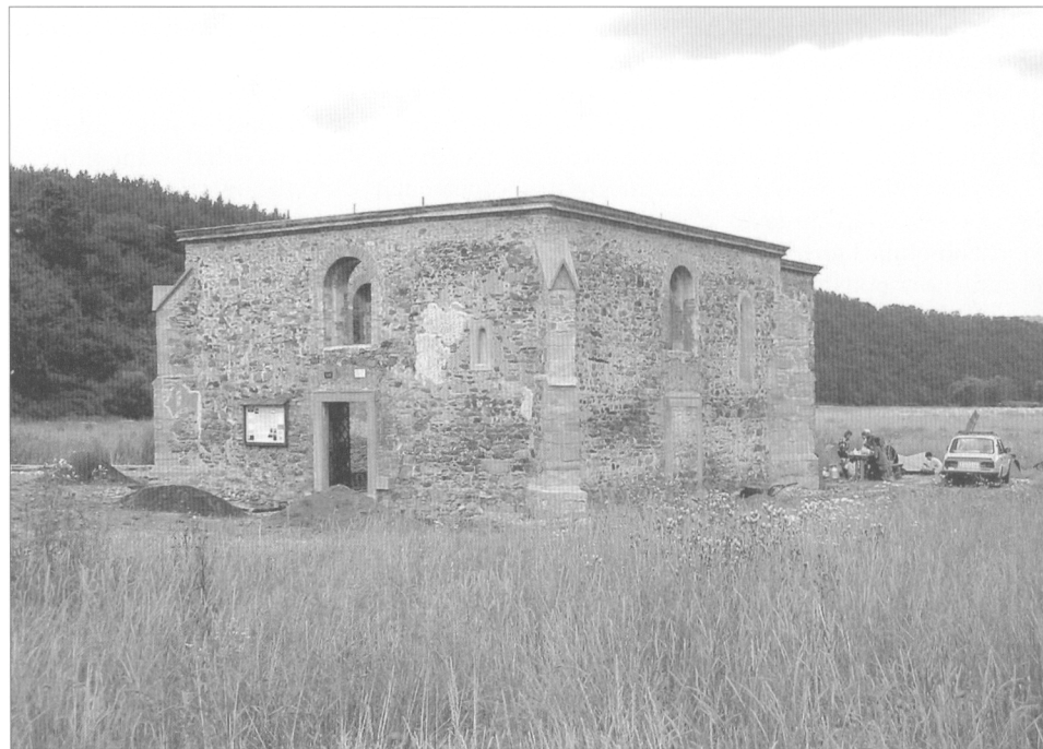
Obr. 2. Celkový pohled na kostel sv. Petra a Pavla po obnově v roce 2004 (od jihozápadu). Dolany, k. ú. Hlince, okres Plzeň-sever.
