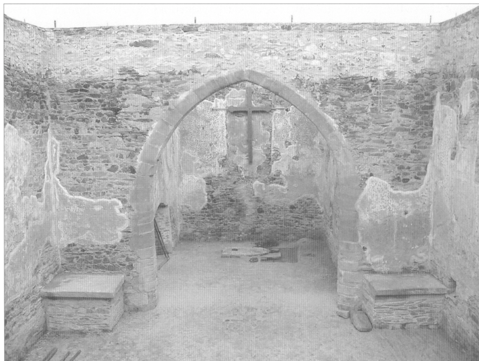
Obr. 5. Dolany, kostel sv. Petra a Pavla – pohled do interiéru.
