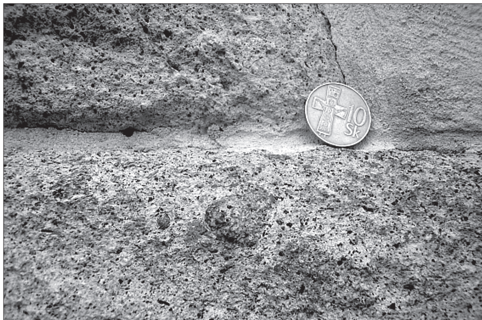
Obr. 5. Kváder dole a vľavo vytvorený z tufu s viditeľnými zrnami tmavým minerálov a zaoblených lapíl. Južná strana apsidy.
