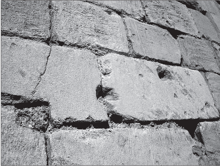
Obr. 11. Kvádre belavých vápencov s dierami po strelách (?). Na niektorých kvádroch hore vidno povrchovú úpravu ryhovanie. Vľavo sa nachádza kváder v tvare L, medzera medzi kvádrami vyplnená tehlou. Jeden kváder je prasknutý.
