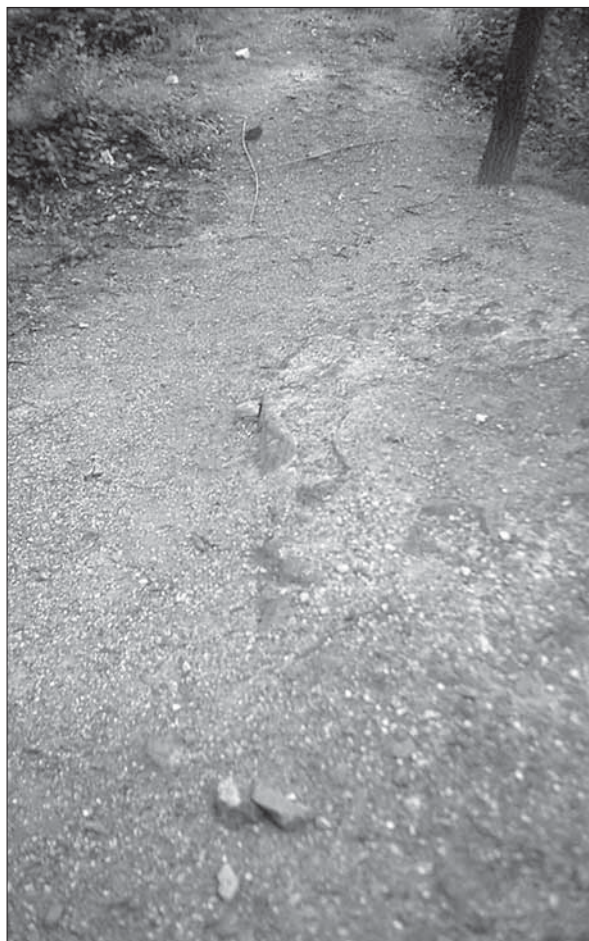
Obr. 8. Karlík, hrad, k. ú. Mořina, okr. Beroun. Reliéfní reliktní nádvorní stěny čelní stavby s vystupujícími kameny jejího vnitřního líce. Stav v roce 2003. Foto autor.
