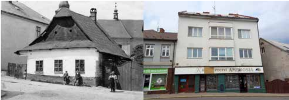
Obr. 2. Ústí nad Orlicí, čp. 32. Vlevo původní dům čp. 32 zbořený v roce 1926, fotografie ze sbírek Městského muzea v Ústí nad Orlicí; vpravo dnešní stav. Foto D. Vích, 2022.
