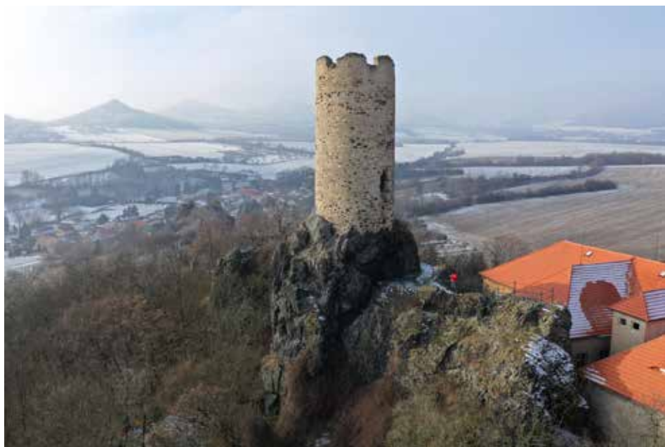
Obr. 8. Věž hradu Skalka v pohledu od východu. Foto M. Benda.
