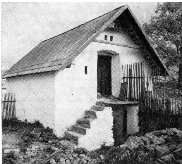
Obr. 10. Jetenovice (okres Strakonice), sýpka v usedlosti čp. 51. Příklad výstupu do komory v patře vnějším schodištěm, užívajícím boční zidky šije u sestupu do sklepa. Nástup je v tomto případě novodobý, vzniklý při nástavbě patra na starší zemní sklep ve 20. století. Foto autor.
