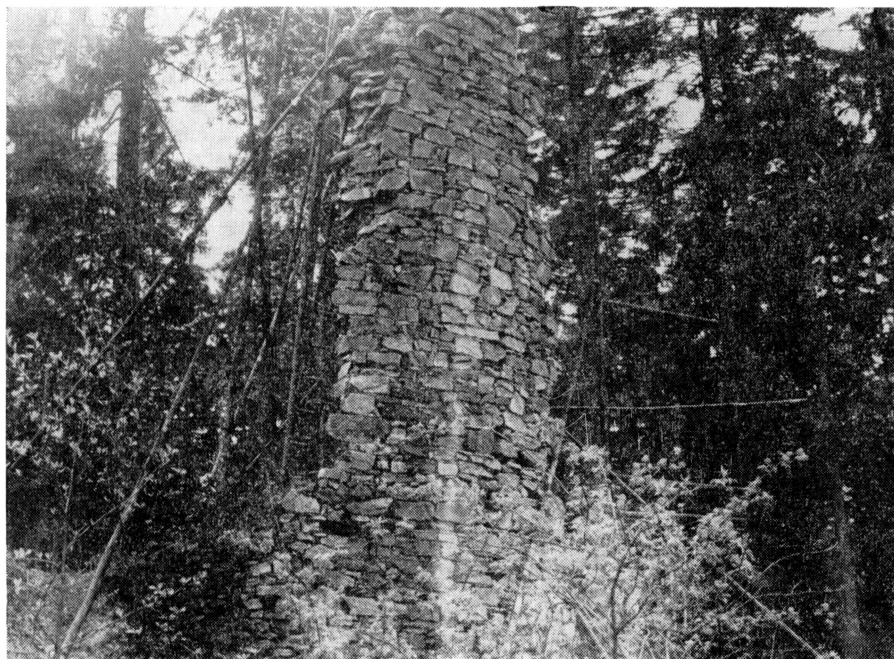
Obr. 3. Hrad Janštejn u Horních Dubenek (okr. Jihlava). Pohled na zbytky válcové věže. Foto Z. Měřínský.
