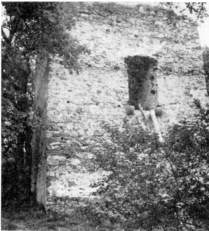
Obr. 11. Pozdněgotická předsunutá věž před Cornštejnem.
