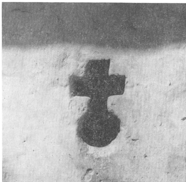
Obr. 4. Koterov čp. 7. Křížková střílna ve vstupní stěně sýpky.
