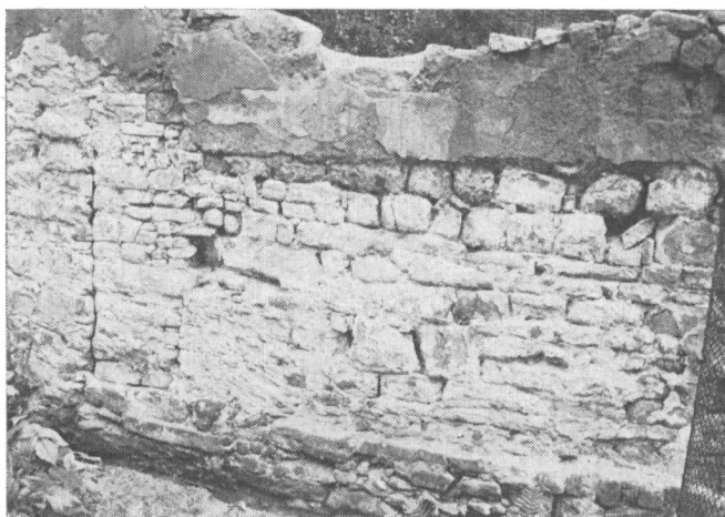
Obr. 8. Vnější jižní strana věže
