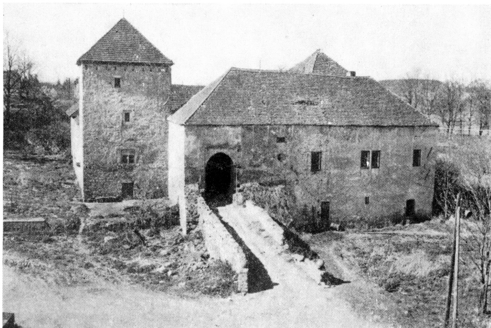
Obr. 9. Kestřany – Horní tvrz při pohledu z 2. patra zámku, stav před započatím zabezpečovacích prací. Sondy zachytily fragmenty trojdielných oken čelního paláce, na nárožní věži dochovány kapsy vzpěr bývalé hrázdné nástavby. (Foto V. Uher)
