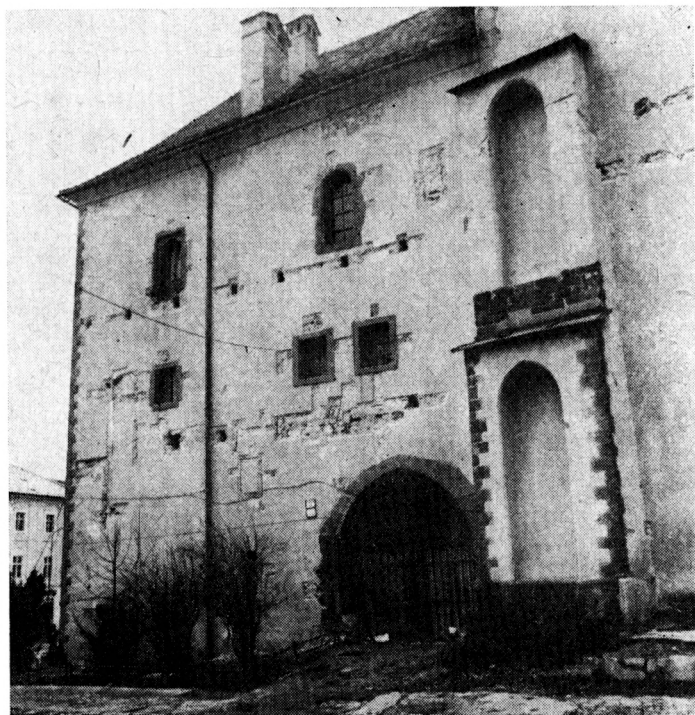
Obr. 6. Mestský hrad v Banskej Bystrici, vstupná časť s barbakánom, severovýchodná fasáda objektov pri veži po sondáži. Foto E. Fillová.
