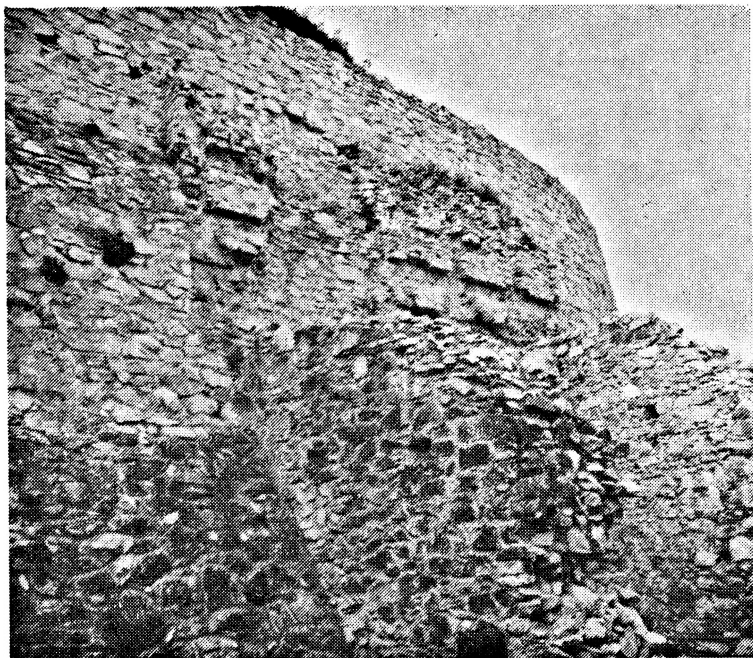
Obr. 2. Rábí, hrad, okr. Klatovy. Zděné výplně boční stěny hrázděného patra 2. brány na vnějším líci torionu. Foto PÚ Plzeň.
