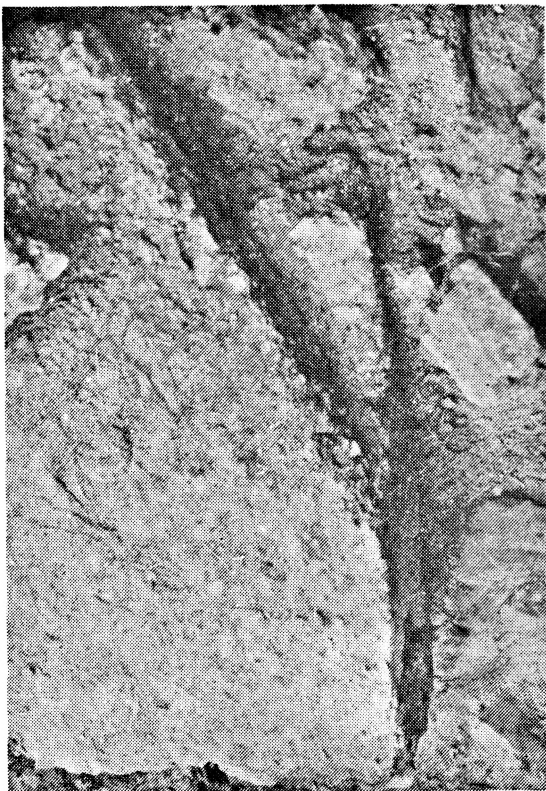
Obr. 12. Týřov hrad, k. ú. Karlova Ves, okr. Rakovná. Sonda LXII. Zbytky hrázděné stěny. Na středním bloku patrné otvory po dřevěných čtverhranech, které sloužily k fixování mazaniceové výplně. Foto autor.
