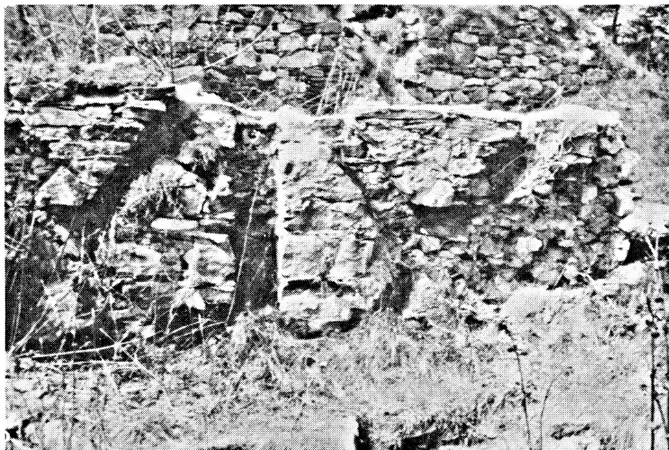
Obr. 4. Hartenštejn hrad, k. ú. Bochov, okr. Karlovy Vary. Otisk trámové konstrukce ve stěně přístavku v nádvoří hradu. Foto autor.
