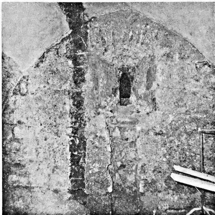
Obr. 5. Severní okno východní stěny velkého sálu s druhotně vylámanou větrací šachtou.
