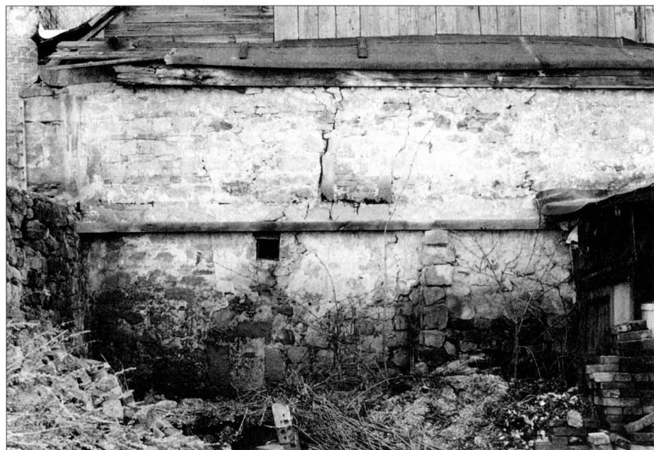
Obr. 6. Severní stěna gotické části objektu s gotickými okny a nárožní armaturou.
