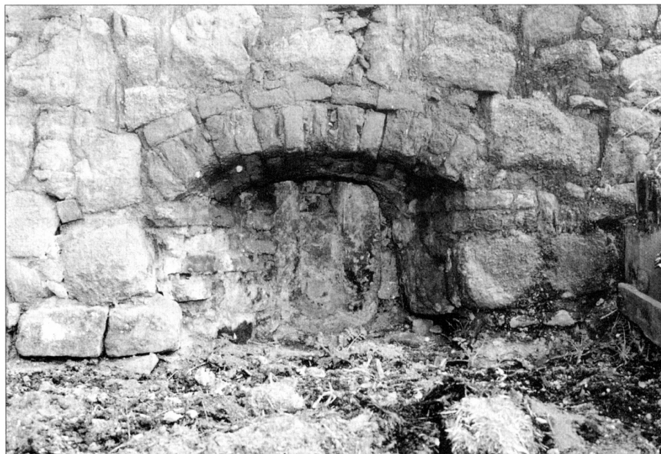
Obr. 5. Otvor „střílny“ s pískovcovým ostěním ve východní zdi severní části objektu.
