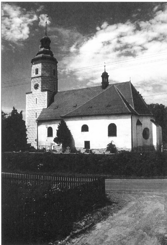
Obr. 3. Brantice, okr. Bruntál. Kostel Nanebevzetí Panny Marie. Celkový pohled od jihovýchodu (M. Zezula, 1999).
