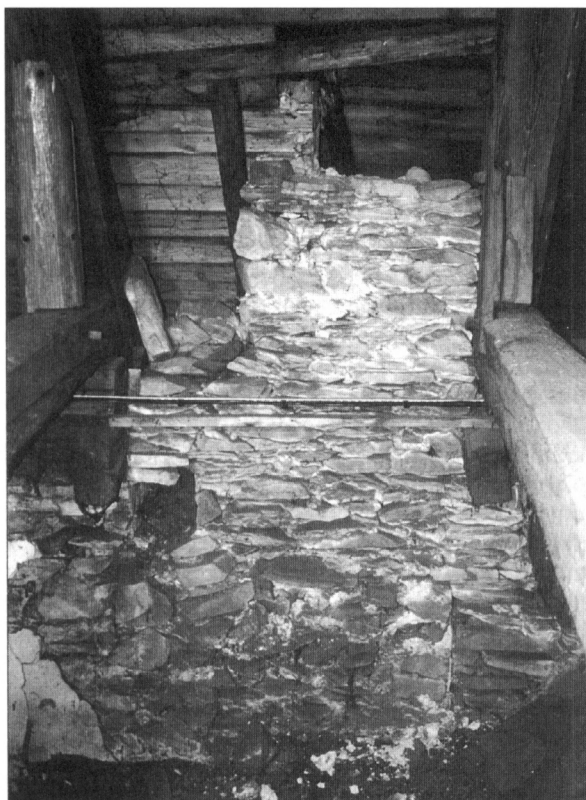
Obr. 16. Brantice, okr. Bruntál. Kostel Nanebevzetí Panny Marie. Zbytky východní zdi lodi se stopami odbouraného renesančního vítězného oblouku a štítu. Vlevo patrné fragmenty omítek plochostropé lodi, vpravo režné zdivo nad klenbou presbytáře (M. Zezula 1999).
