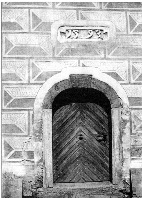
Obr. 6. Brantice, okr. Bruntál. Kostel Nanebevzetí Panny Marie. Věž. Barokní portál v její západní zdi, v r. 1982 obnovené diamantové sgrafito a štukový letopočet s vročením přestavby kostela (M. Zezula 1999).
