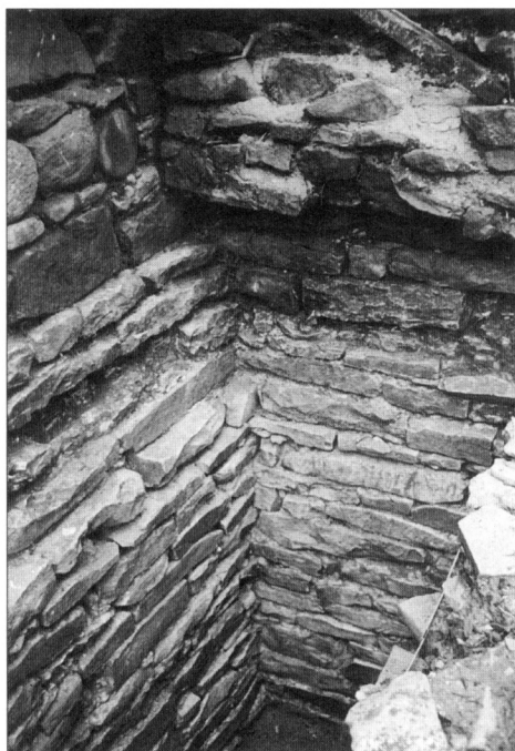
Obr. 7. Stará Boleslav. Napojení románského zdiva severní stěny severní lodi baziliky sv. Václava a západní stěny tzv. Vrábské kaple v sondě 4A. Foto I. Boháčová.
