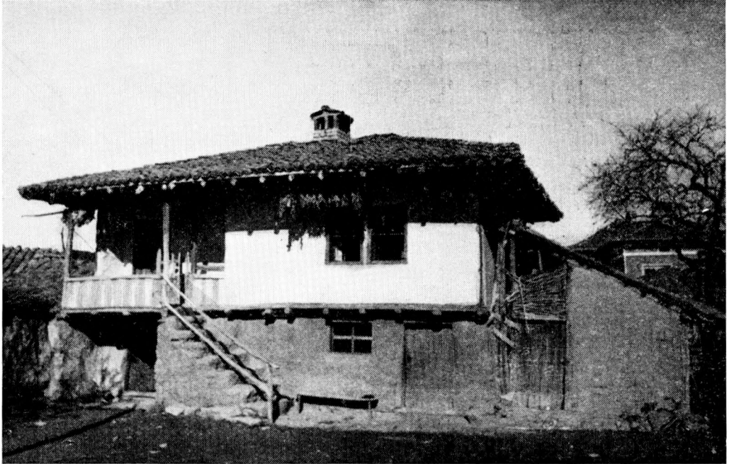
59 Einstöckiges Haus in der Gemeinde Ognjanovo (Sofia). Foto B. Georgieva.
