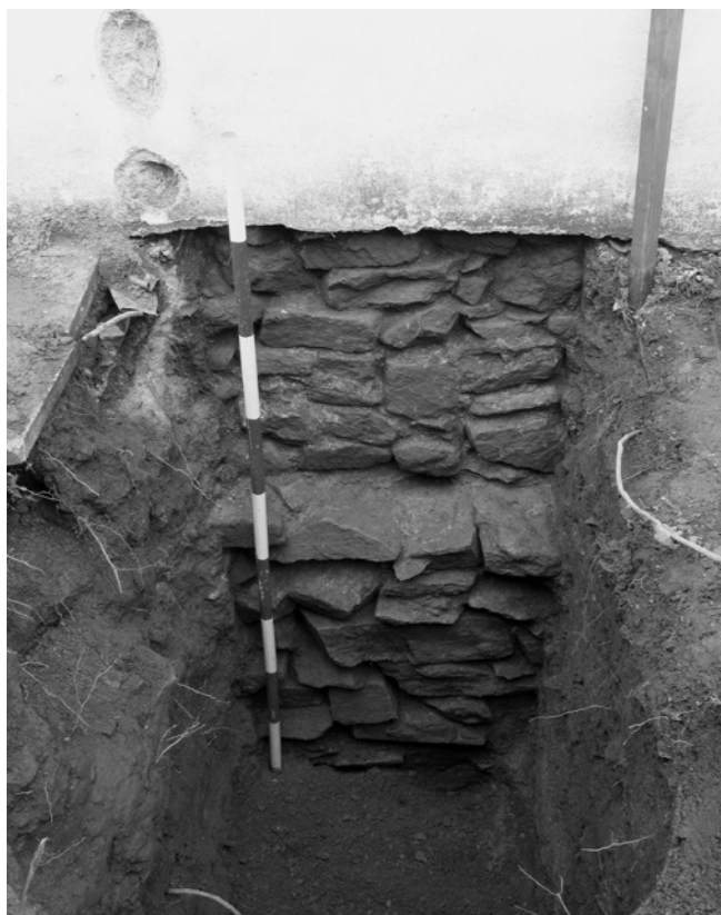
Obr. 120. Pošná. Rozšířený předzáklad na severní straně lodi (statická sonda S3). Foto P. Hejhal, duben 2008.
