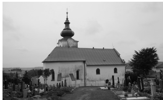
Obr. 98. Krucemburk. Kostel sv. Mikuláše, pohled od severu. Foto P. Hejhal, srpen 2006.
