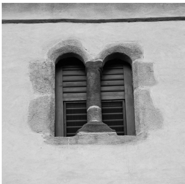
Obr. 110. Hněvkovice. Kostel sv. Bartoloměje, sružená okna ve východní zdi věže. Foto P. Hejhal, květen 2012.
