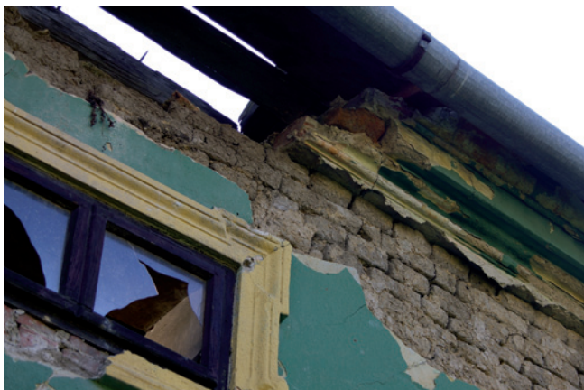
Obr. 5. Detail profilování korunové římsy provedené u hliněného objektu z pálených cihel. Uhřetice čp. 34.
