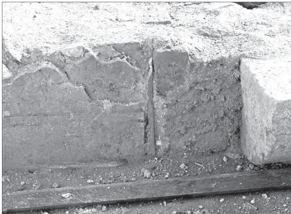
Obr. 11. Detail pozdně gotického krakorce vloženého do původního okénka v severní obvodové stěně objektu CO16. K okénku se vztahují dvě vrstvy gotických omítek, mladší s černým kvádrováním. Foto archiv Archaia Brno, o. p. s. (inv. č. 15895-2008).
