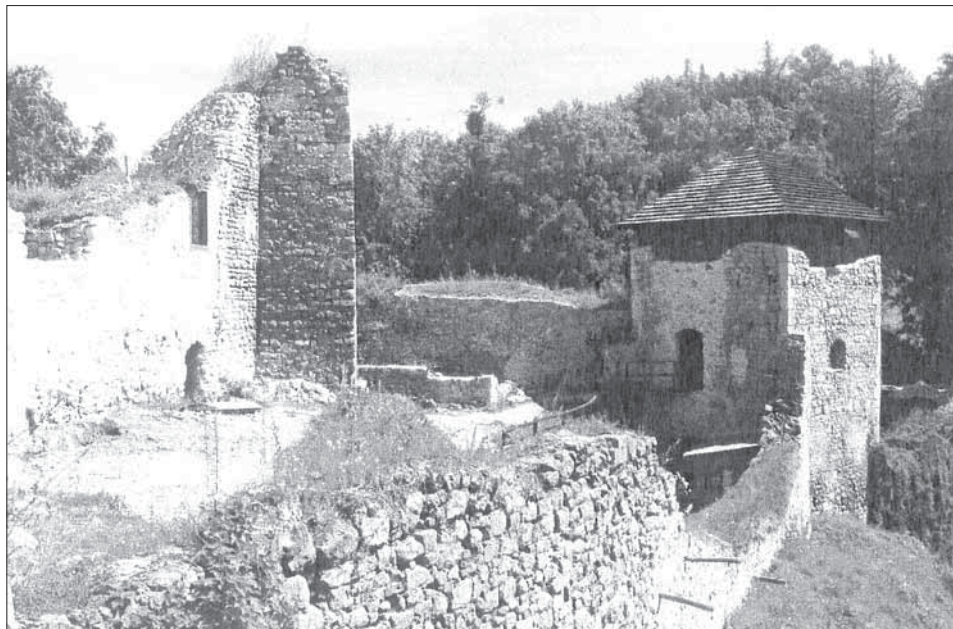
Obr. 2. Hrad Lukov. Pohled od západu na odkryté a opravené torzo jižního průčelí východního paláce (vlevo nahoře) a na část obvodové hradby se vstupní věžovitou branou a zbytky přilehlého hospodářského stavení. Stav z roku 2009.
