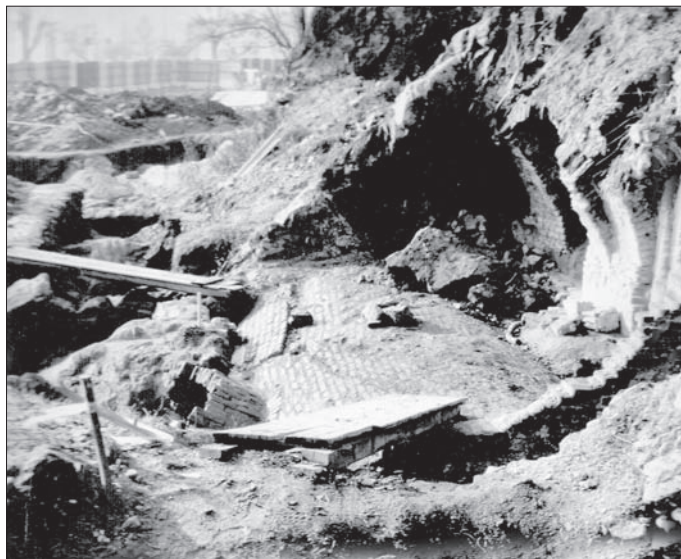
Obr. 4. Bratislava, Vydrica, riešené územie V1, relikty domu č. 12. Odkrytá tehlová klenba 1. nadzemného podlažia. Medzi tehlovými pásmi renesančnej klenby je vstup do skalného priestoru K1 v úrovni 2. nadzemného podlažia. Foto O. Novotová, 2007.
