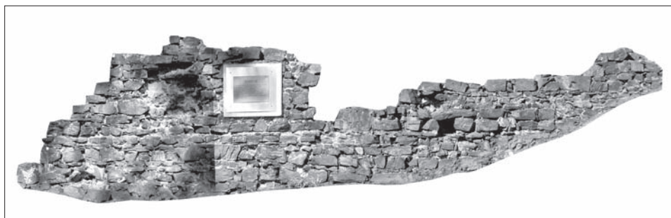
Obr. 7. Nezvěstice. Jihovýchodní obvodová zeď, rozvinutý plášť. Stav v roce 2007. Zaměření GEO-CZ.
