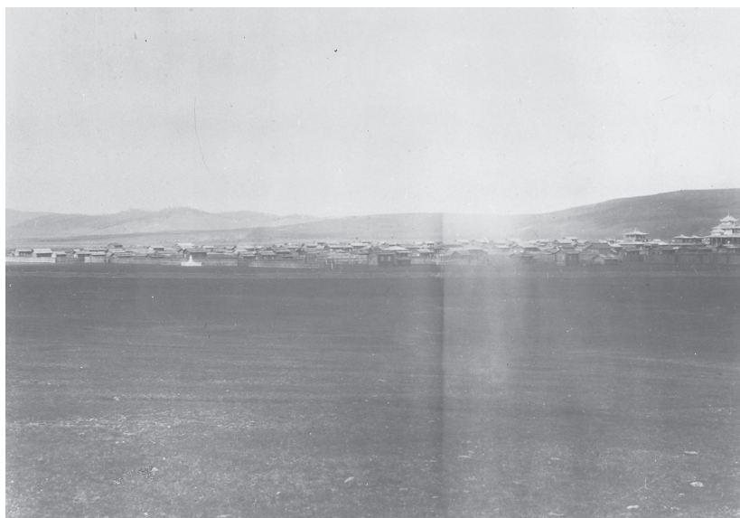
Obr. 8 – Původní Egitský klášter. Pohled na klášterní komplex, hlavní chrám z jihovýchodu, počátek 20. století.
