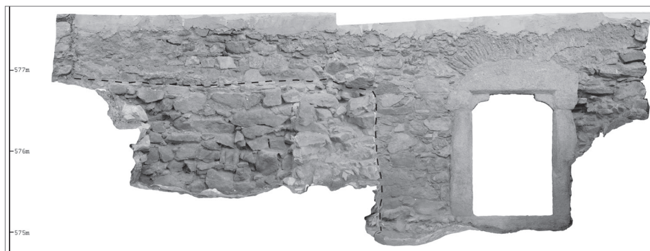
Obr. 7. Tvrz Řesanice, okr. Plzeň-jih. Fotogrametrie průčelí černé kuchyně v úrovni sklepa se sedlovým portálem s okosenými hranami. Vytvořil J. Švejnoha.
