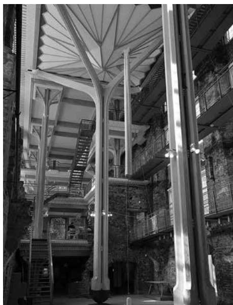
Obr. 15. Ochranná konštrukcia kráľovského hradu vo Vejle v Dánsku vo forme výtvarného diela, ktoré je kotvené vnútri torza a nezaťažuje obvodové múry. Zdroj http://upload.wikimedia.org/wikipedia/commons/thumb/7/73/Koldinghus_-_Old_castle_in_Kolding_-_Denmark_009.jpg/400px-Koldinghus_-_Old_castle_in_Kolding_-_Denmark_009.jpg , cit. 20. 1. 2015.
