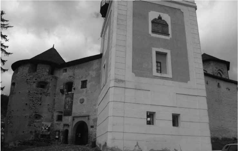
Obr. 23. Rôzny spôsob prezentovania hradieb okolo Starého zámku v Banskej Štiavnici. Lavá strana od veže je konzervovaná s originálnou omietkou, pravá strana rekonštruovaná s novou omietkou. Foto Z. Ondrejková.
