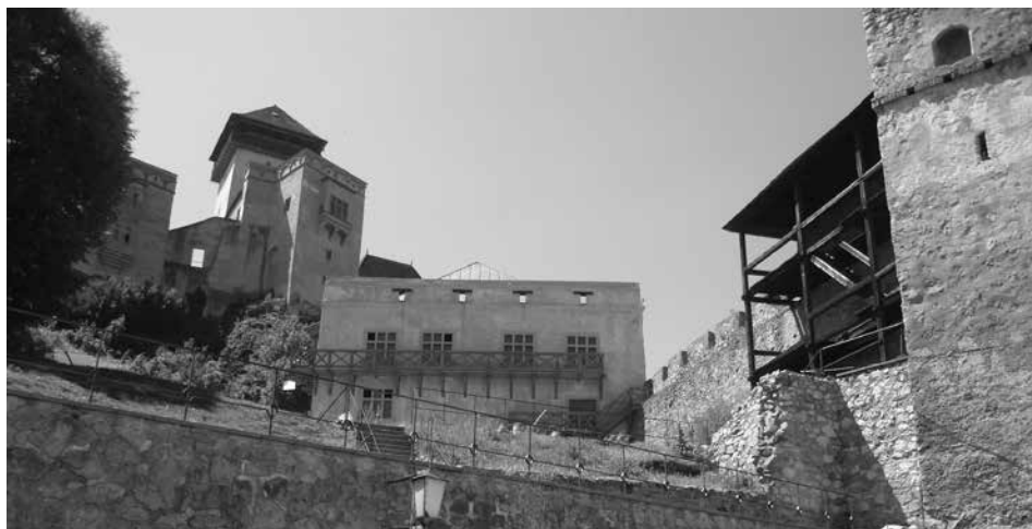
Obr. 20. Rekonštrukcia objektu kasárni na Trenčianskom hrade kontinuálne nadväzuje na rámcovú metódu obnovy stanovenú v 50. rokoch. Foto Z. Ondrejková.
