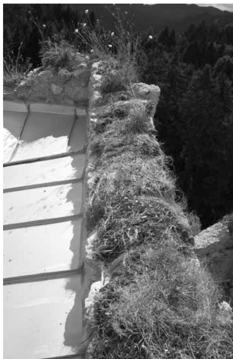
Obr. 19. Styk plochej strechy veže na hrade Lietava s obvodovou stenou, ktorá je ukončená zatrávňovacou korunou. Foto Z. Ondrejková.
