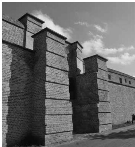
Obr. 27. Veža mestského opevnenia v Trnave upravená do podoby architektonizovanej ruiny. Horizontálne pásy zubovania tehlových riadkov predstavujú náznak pokračovania pôvodnej konštrukcie. Nezachované časti murív veže sú prezentované v dlažbe. Foto A. Škrinárová.
