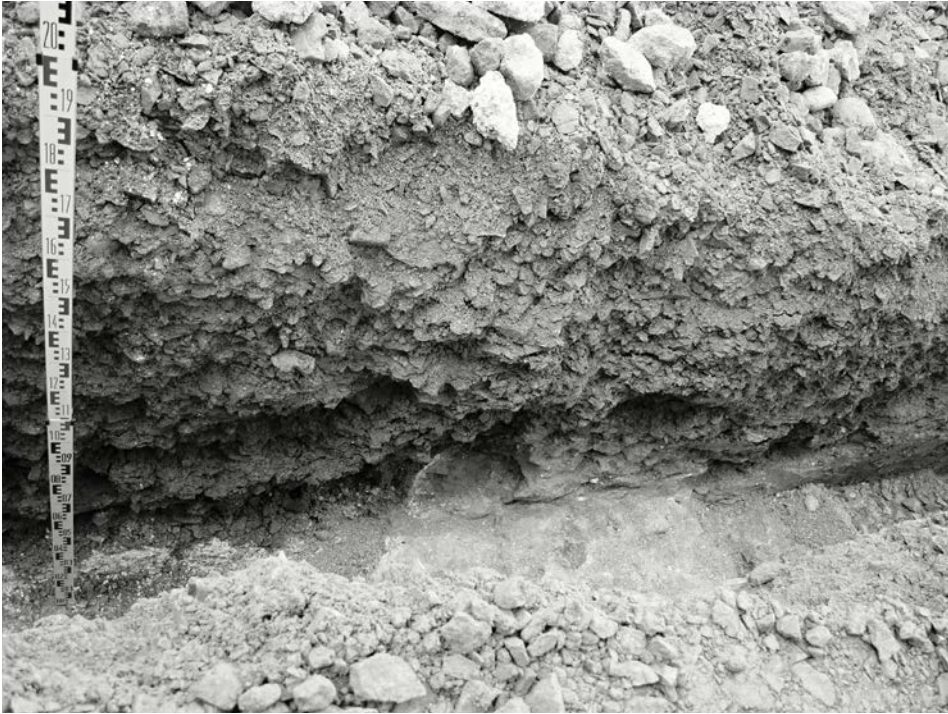
Obr. 15. Kremnica – Mincovňa Kremnica. Výskum v roku 2010. Pohľad zo severovýchodu. Objekt 2/2010 v ryhe pre kanalizáciu. Foto J. Beljak.
