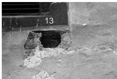
Obr. 17. Košice, Urbanova veža. Sonda 13 (45×26 cm) pod kamenným rámom parapetu veľkého zvukového okna s kamenným rámom ukončeným lomeným oblúkom, na trefom poschodí veže na západnej strane.
