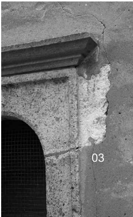
Obr. 16. Košice, Urbanova veža. Nálezová situácia 03 v hornej časti vedľa kamenného rámu okna s archivolťou pod rímsou na pravej (južnej) strane na západnom priečeli. Abb. 16. Košice, Urban-Turm. Fundsituation 03 im oberen Teil neben dem Steinfensterrahmen mit Archivolte unter dem Sims auf der rechten (südlichen) Seite an der Westfassade.
