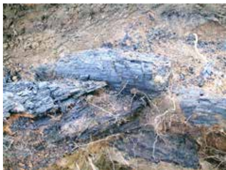
Obr. 5. Křížení trámů vnějších stěn 305 a 307 dřevohlinité bašty.
