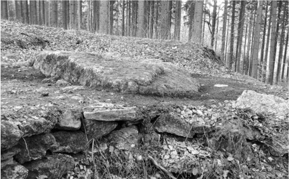
Obr. 10. Skála vystupující z prvního valu, k níž byl ukotven most do brány hradu. Pohled z příkopu od jihovýchodu. Vpředu nasucho kladená zeď zpevňující nájezd, v pozadí val a místo brány.
