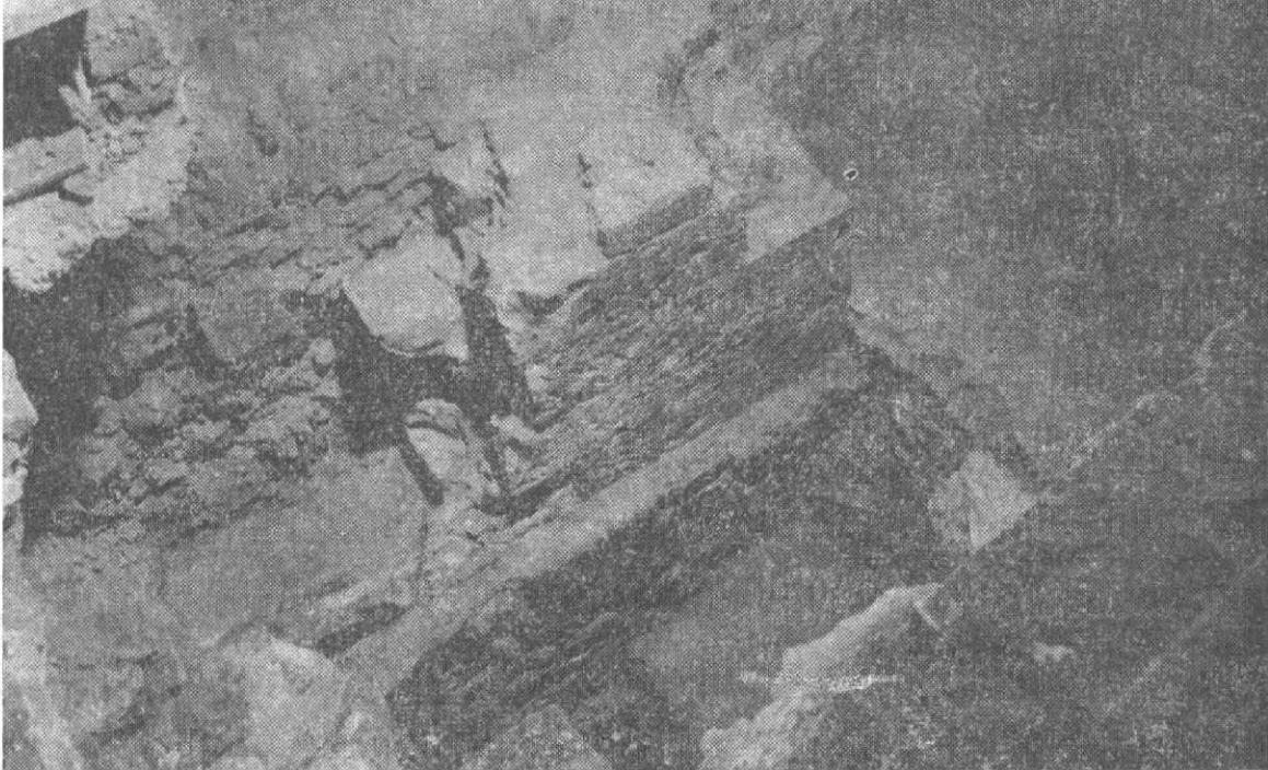
Obr. 2. Praha 1, kostel sv. Martina ve zdi. Nároží uvnitř kostela. Nadzemní část vyzděna dochovanými čtyřmi řádky pečlivě opracovaných kvádrů, dole rozšířený základ. Vpravo klenba barokní krypty, vlevo nahoře gotická zeď, vyplňující prostor v jihovýchodním nároží. V ní patrný druhotně použitý kvádr. Pohled od severovýchodu. Foto Z. Helfert.
