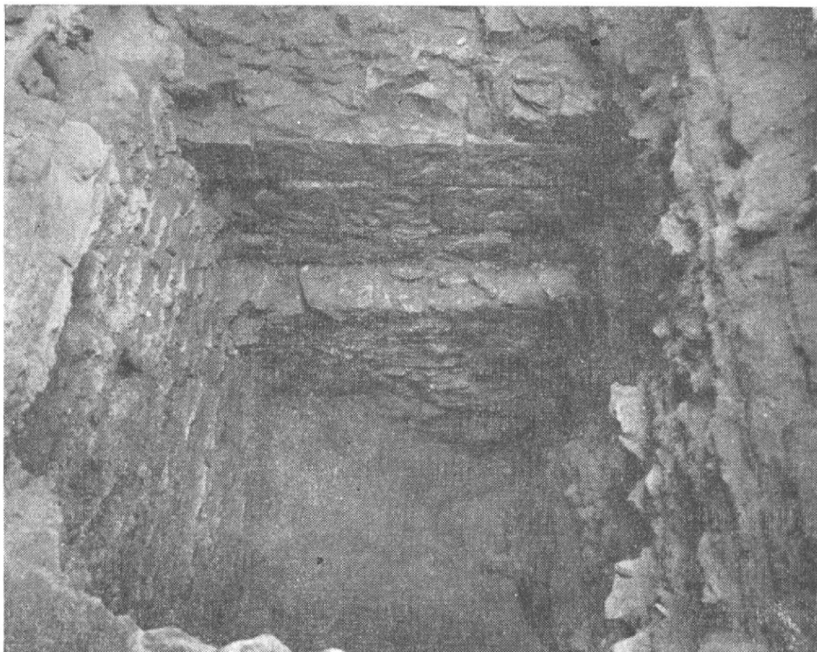
Obr. 3. Praha 1, kostel sv. Martina ve zdi. Vnější líc jižní stěny románského kostela s třemi řádky nadzemního zdiva a s rozšířeným základem. Vlevo cihlové zdivo novověké hrobky. Pohled od jihu. Foto Z. Helfert.
