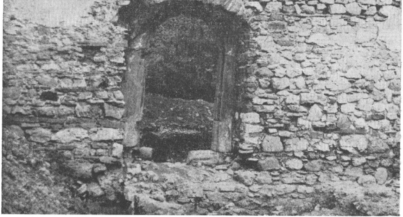
Obr. 3. Cezúra v západnom obvodovom múre-interiér. Foto Tóthová.
