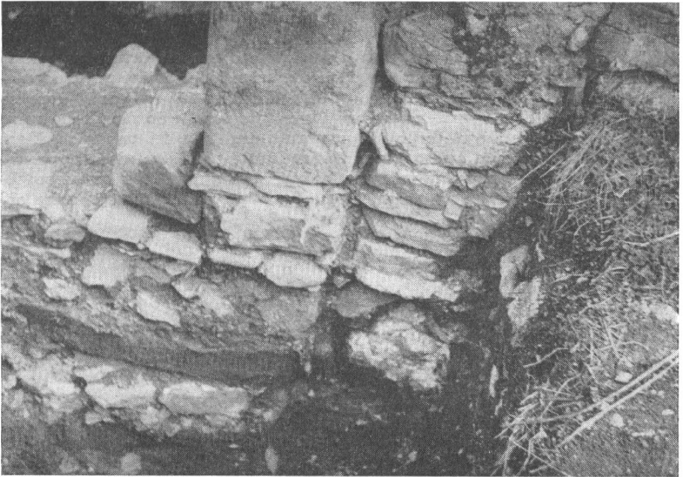
Obr. 5. Detail stavebnej cezúry v západnom obvodovom múre-exterier. Foto Tóthová.
