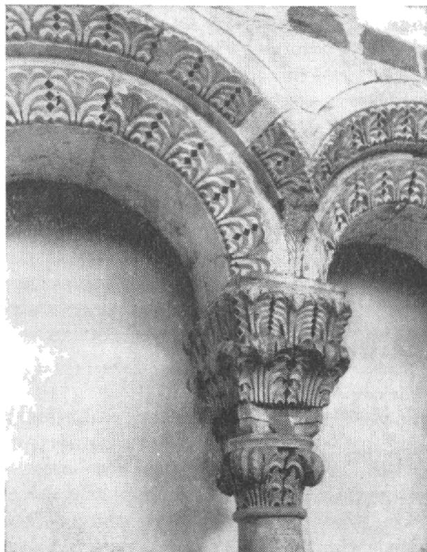
Obr. 6. Olomouc, „Přemyslovský palác“. Detail románského okna západní stěny. Stav po restauraci. (Foto M. Valušková.)
