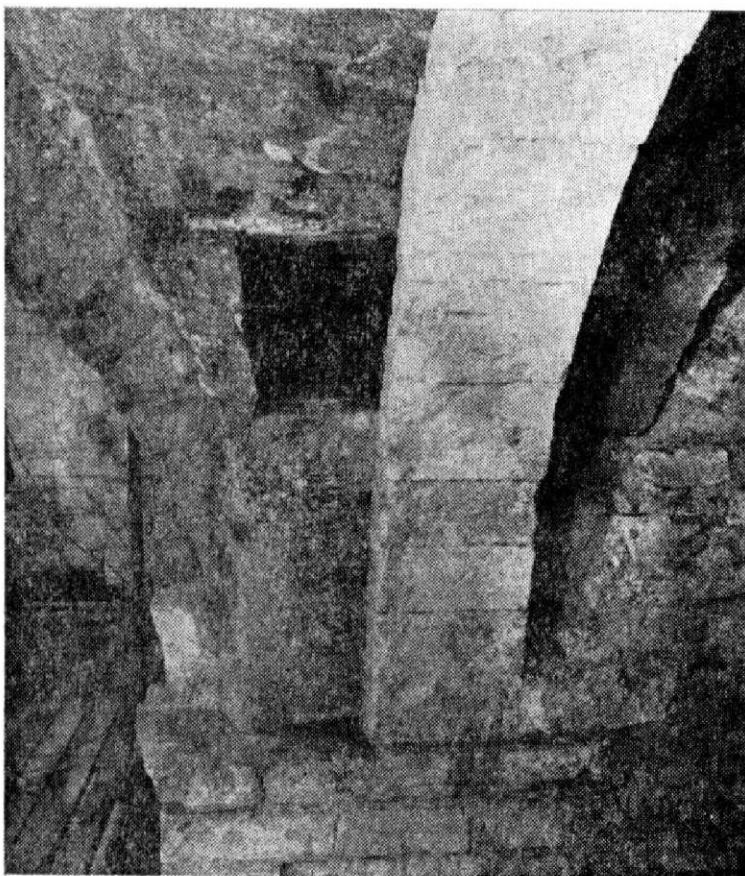
Obr. 7. Čp. 548/I. Praha-Staré Město. Pohled k jihu na severní líc kvádrového pilíře s klenebním pasem a klenebním svodem, do kterého byla zabudována schránka. Na svodu zřetelné otisky bednění klenební skruže. Vpravo od pasu je k pilíři a svodu přídána příčka z roku 1496. Foto: Helfert – PSSPPOP.
