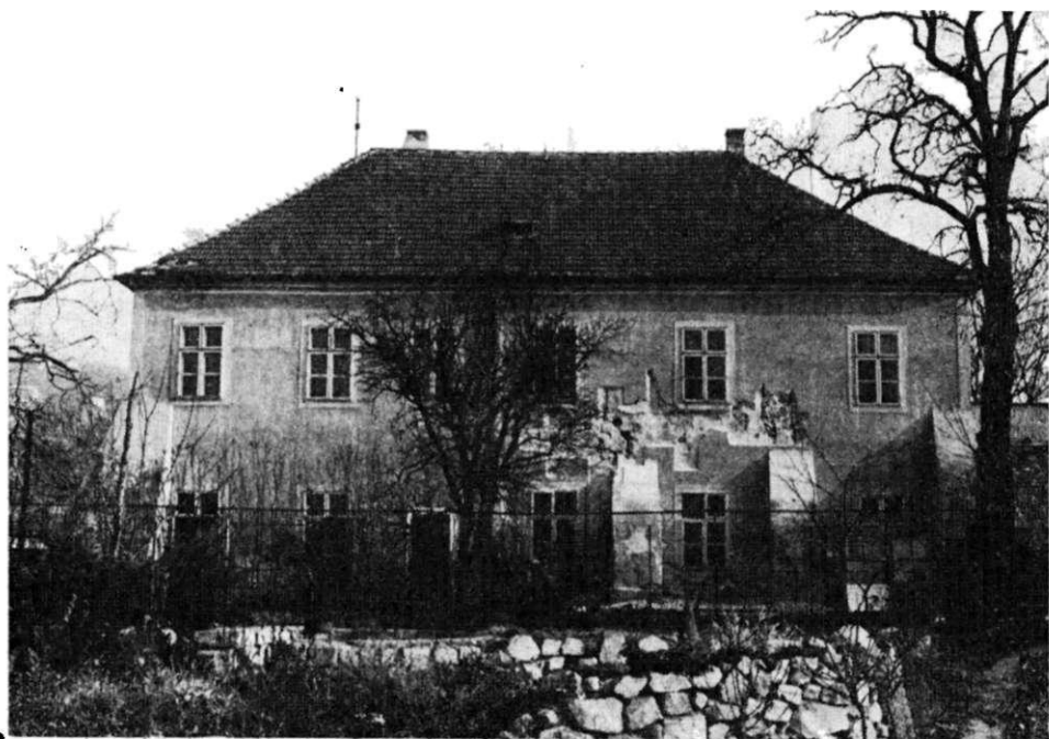
Obr. 4. Bratislava — Devín, kaštieľ na Hutnickej ul. č. 25. Pohľad na JZ fasádu objektu.
