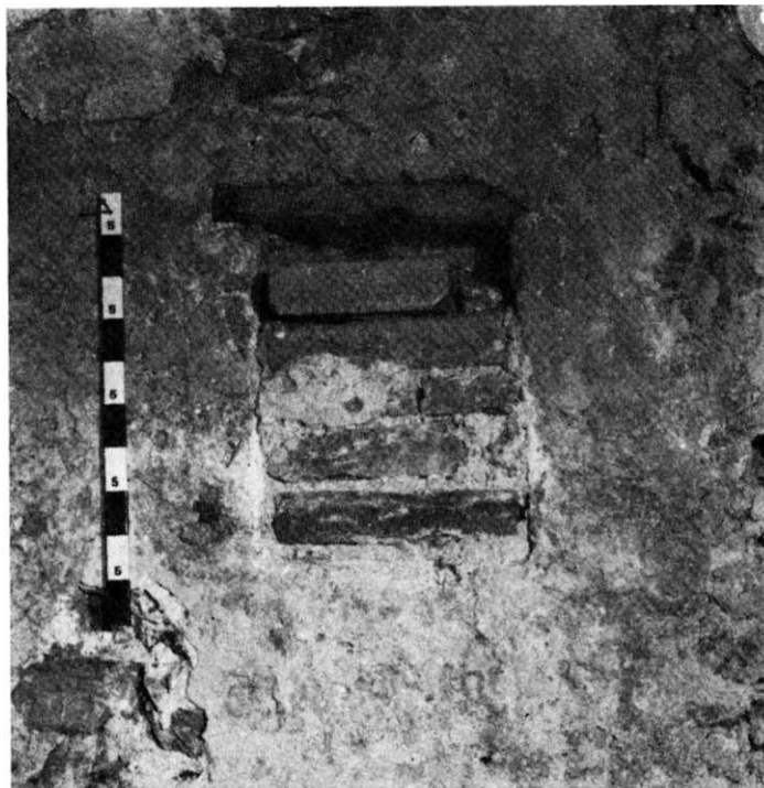
Obr. 7. Bratislava — Devín, kaštieľ na Hutníckej ul. č. 25. Okienko z III. etapy (5).
