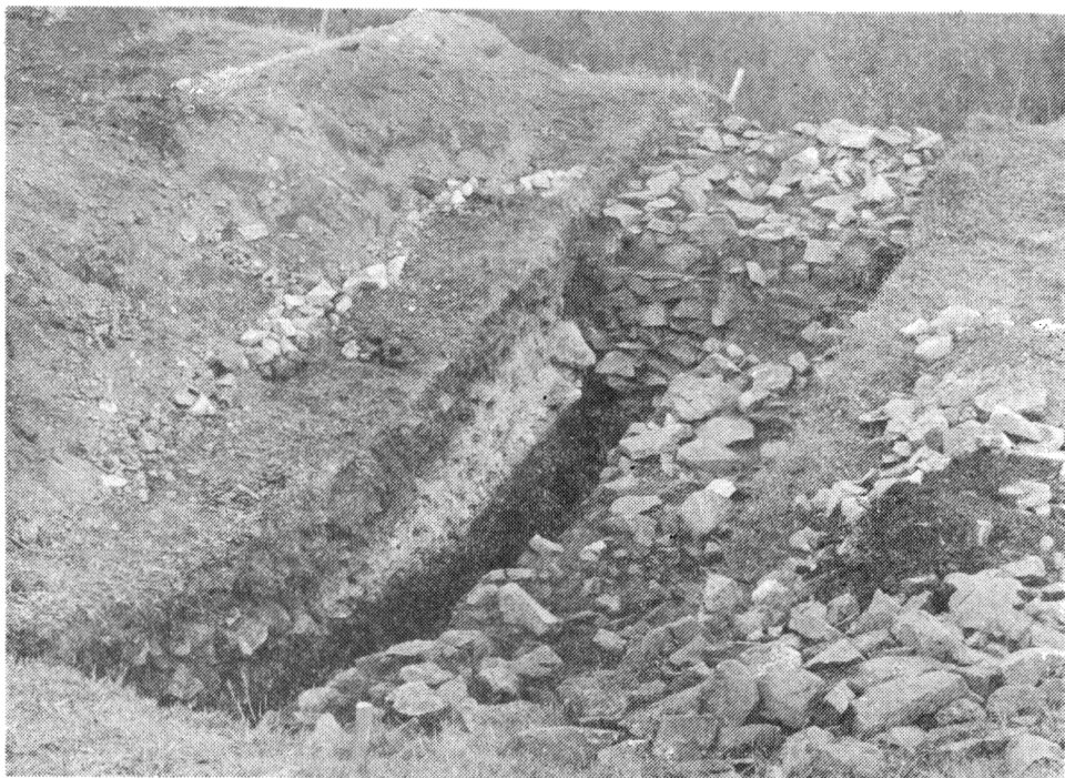
Obr. 5. Zelená Hora, okr. Vyškov 1963. 1 — pohled shora od sv na vnitřní strukturu středověké hradební zdi v sondě B; před zdi jsou zbytky velkomoravského opevnění; 2 — pohled od szz na vnitřní stěnu středověké hradební zdi a na její destrukci v sondě B.
