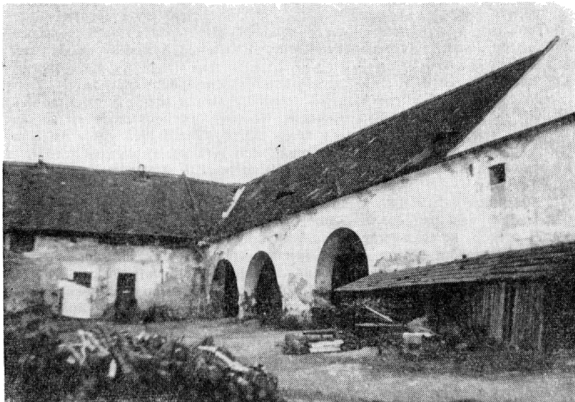
Obr. 8. Dub — foto východního křídla.
