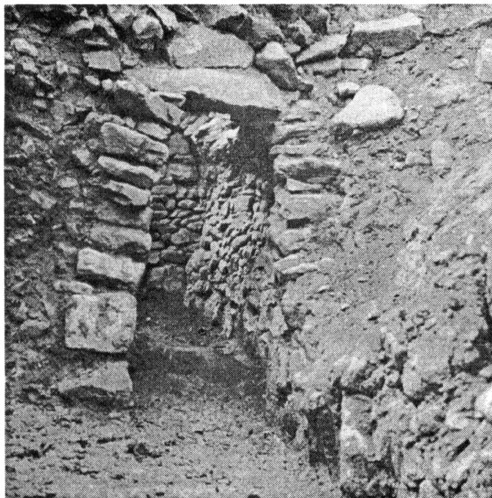
Obr. 10. Mstěnice. Sklepní prostor pod jizbou domu XII.
