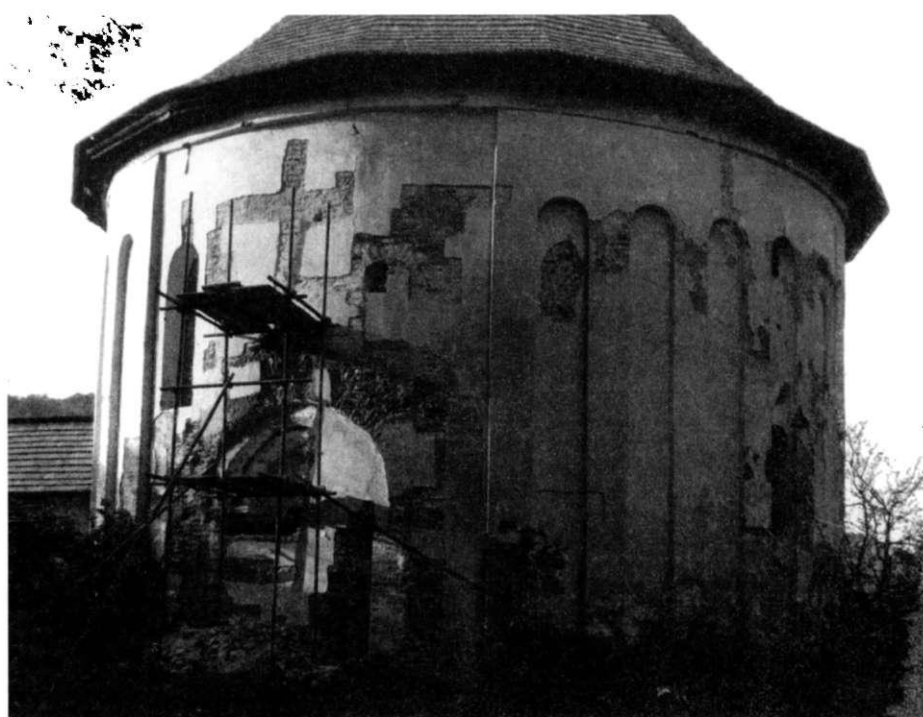
Obr. 2. Rotunda počas výskumu fasády.
