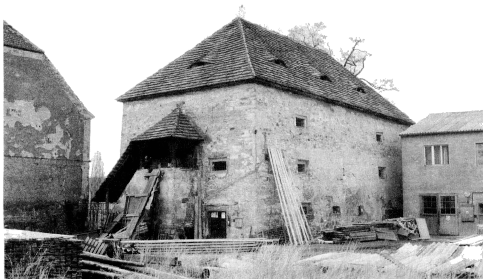
Obr. 4. Malá Dobrá. Celkový pohled na sýpku od jihovýchodu. Foto Miroslav Fuchs.
