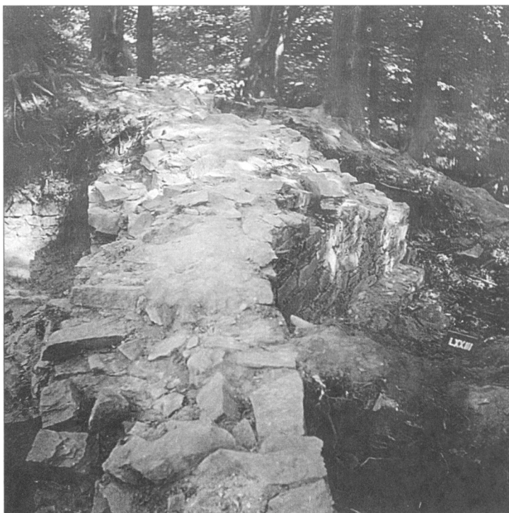
Obr. 6. Břít podkovovité věže vybíhající před vnější líc hradby (fotoarchiv VMO).
