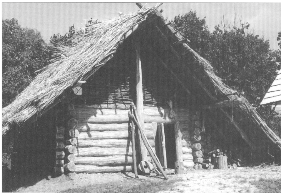
Obr. 5. Modrá, archeologický skanzen, objekt pekárny srubové konstrukce s vyplétaným štítem a rákosovou střešou. Foto autor.
