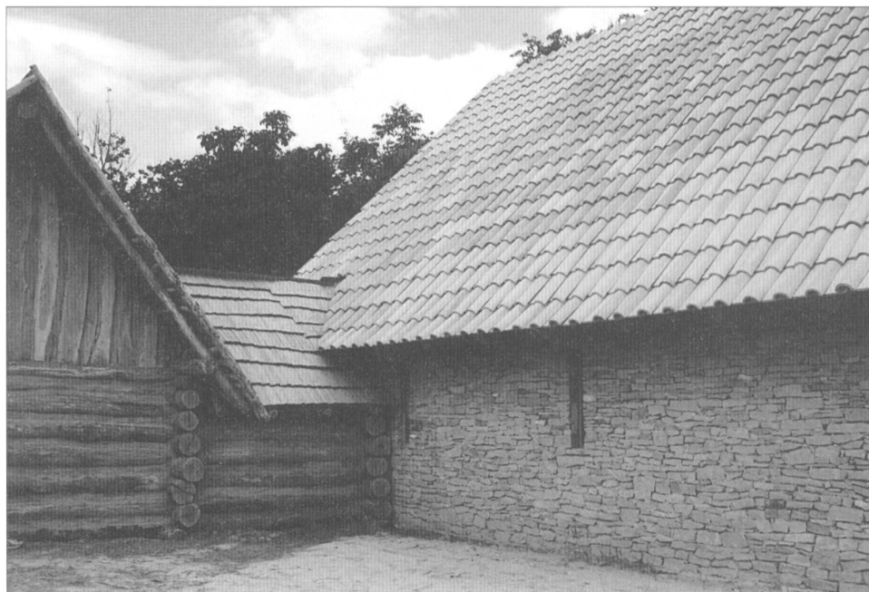
Obr. 7. Modrá, archeologický skanzen, část srubu s šindelovou střechou a část hypotetické rekonstrukce stavby palácového typu se střechou z hliněných komponentů antického charakteru mocenského areálu. Foto autor.
