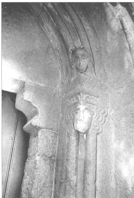
Obr. 7. Detail praveho ostenia južného portálu v Seni.
