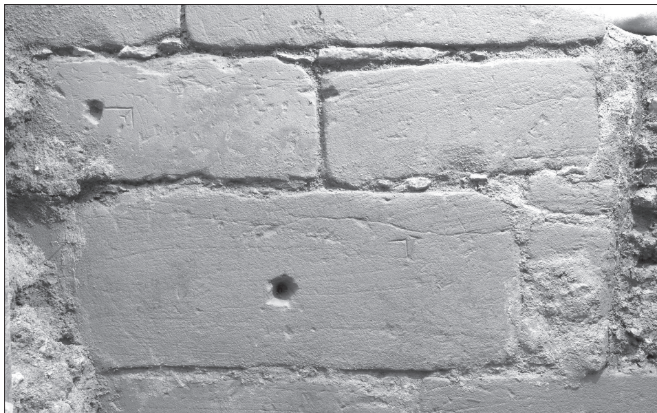
Obr. 3. Severní bok prodloužení mostu s pískovcovými kvádry s důlky pro krepnu a kamenickými značkami. Pohled od severu. Foto M. Frouz.
