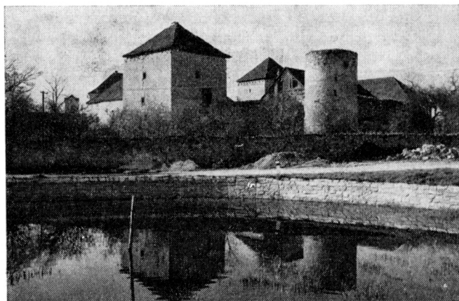
Obr. 10. Staré Kestřany – pohled na areál horní tvrze od severu (foto V. Uher).
