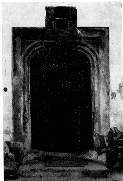
Obr. 2. Parížovce, kaštieľ. Detail vstupného neskorogotického portálu s erbom v nadpraží. Foto Š. Bukčár.
