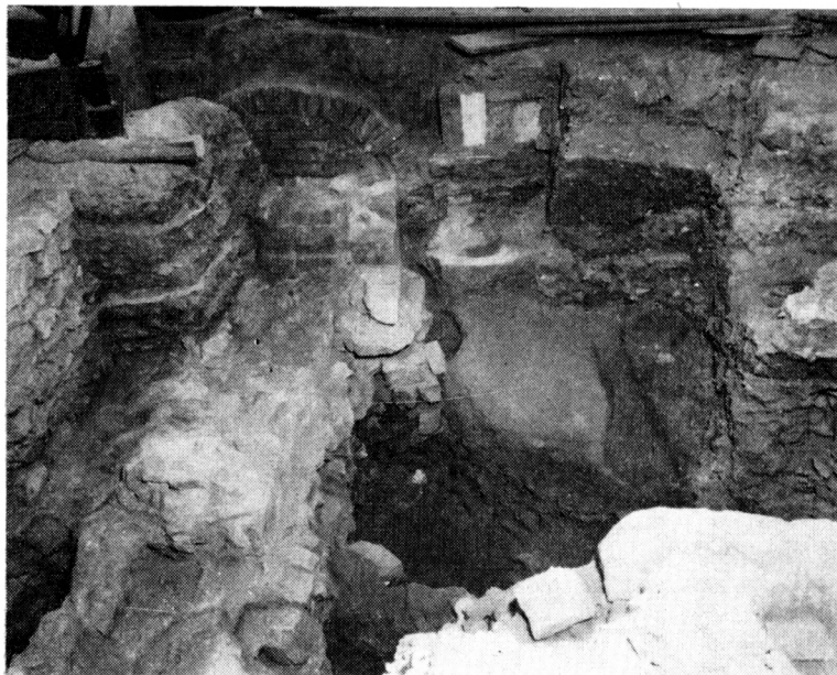
Obr. 2. Praha 1—Nové Město, sv. Kliment. Základová rýha pro apsidu předrománského kostela od východu. Foto Fr. Cáp.
