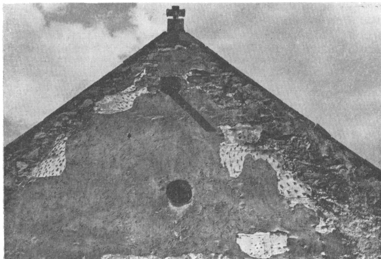
Obr. 10. Bolevec čp. 7. Východní štítová stěna sýpky s rýsovanou osnovou renesančního sgrafita pod opadanou omítkou.
