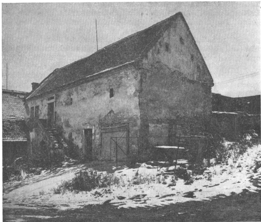
Obr. 16. Bolevec čp. 19. Klasicistní sýpka ze začátku 19. století ve dvoře usedlosti. Ve zdivu nároží je možné sledovat druhotně zabudované části středověkého okoseného ostění. Ve vrcholu štítu je větrací okénko profilu křížkové střílny, levé z dvojice okének pod ním má okosené ostění pozdně gotického tvaru.
