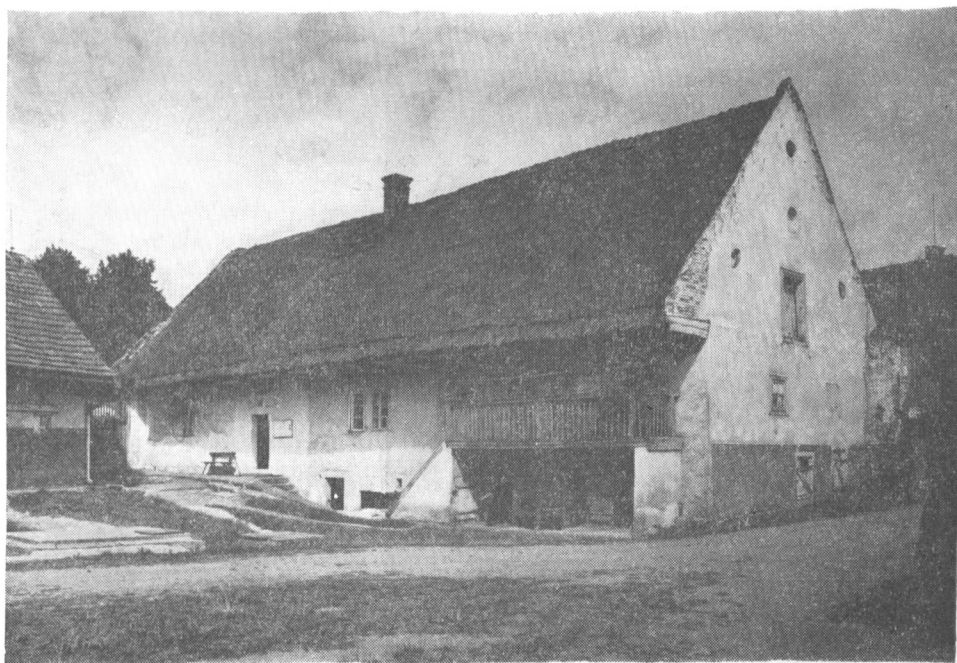
Obr. 7. Bolevec čp. 1. Celkový pohled (k severozápadu) na dům, postavený na začátku 19. století. Ve spodním podlaží jeho (na snímku bližší) zadní hospodářské části jsou sklepy s druhotně užitými částmi pozdně gotických portálů.
