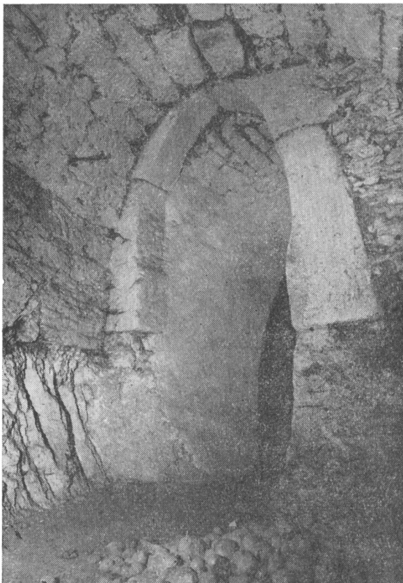
Obr. 3. Božkov čp. 12. Situace hrotitého gotického portálu ve sklepech domu. Patrné je částečné překrytí jeho archivoly klenbou a dodatečné snížení úrovně podlahy sklepa.
