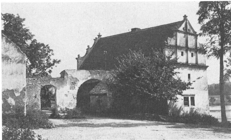
Obr. 7. Příklad renesančního špýcharu z r. 1607, který byl součástí hospodářství s tvrzí v Solopyskách na okr. Příbram.
